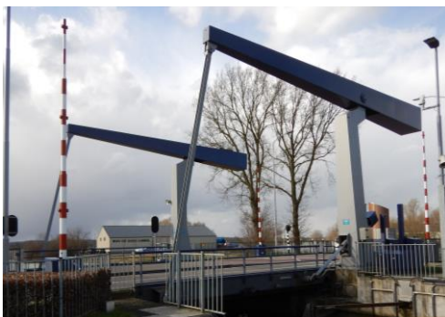
Abbildung 4-20: Beispiele für Waagebalkenbrücke (links) und Klappbrücke mit tiefliegendem Gegengewicht (rechts) (Quellen: CDM Smith, HPA)
